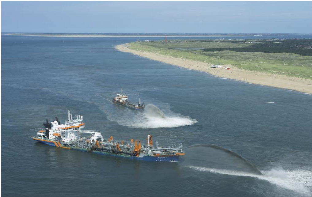
Foto 6.4. Onderwatersuppletie via 'rainbowen'. (Foto Rijkswaterstaat)
