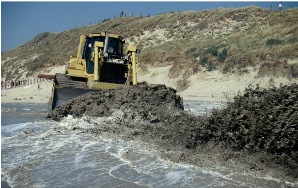
Foto 6.3. Werkzaamheden strandsuppletie. (Foto Rijkswatestaat)
